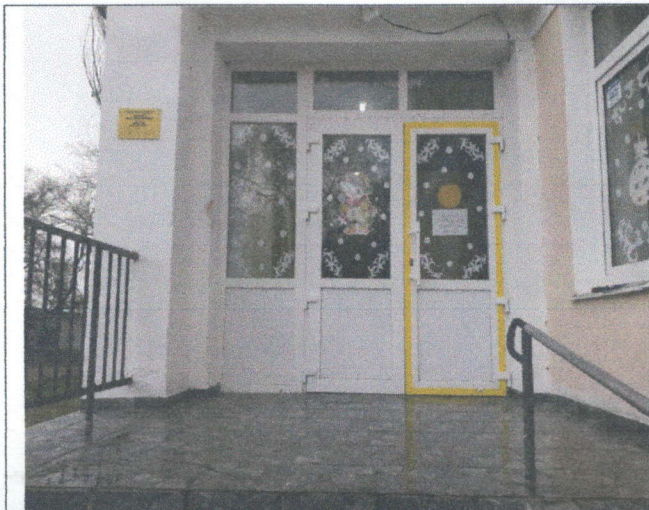
Фото №7 Вход в здание №1 (входная площадка)
