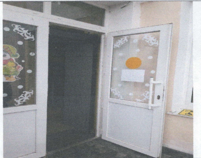
Фото №8 Вход в здание №1 (дверь)
