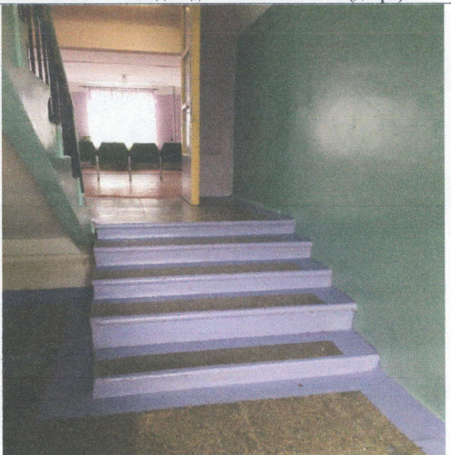
Фото №12 Вход в здание №2 запасной
