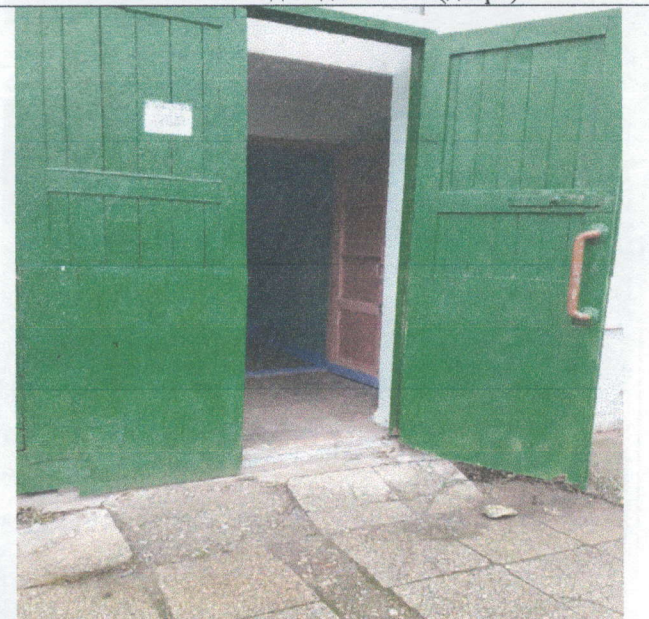
Фото №10 Вход в здание №2 запасной (дверь)
