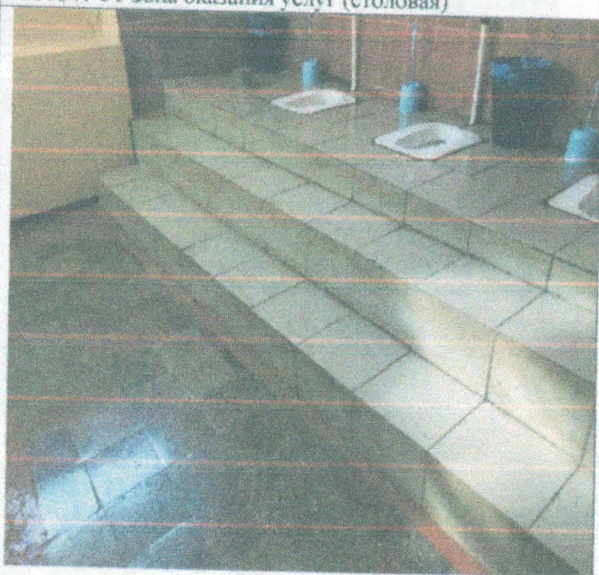
Фото №33 Санитарно-гигиенические помещения
