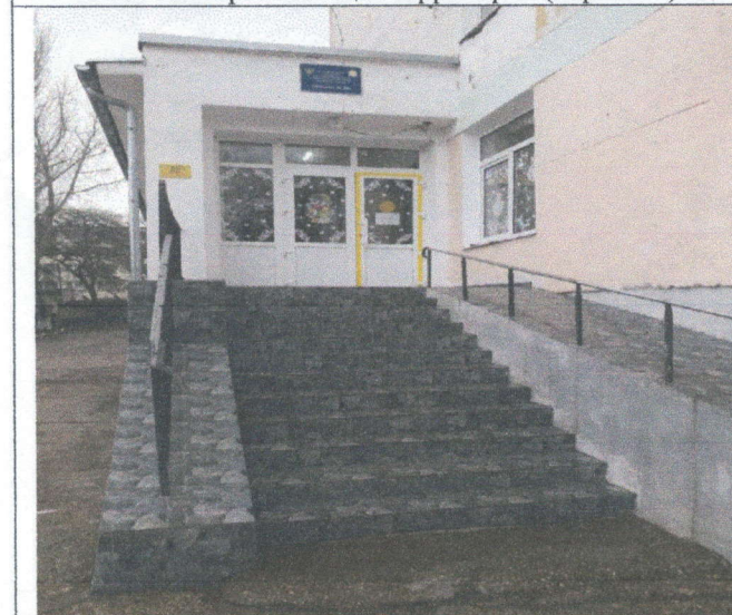
Фото №5 Вход в здание №1 (лестница)
