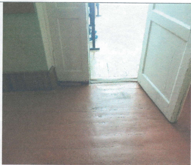
Фото №14 Пути движения внутри здания (двери)
