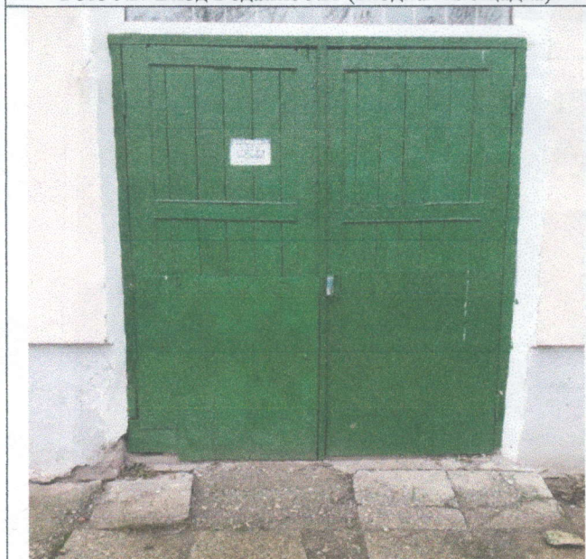
Фото №9 Вход в здание №2 запасной(вх. площадка)
